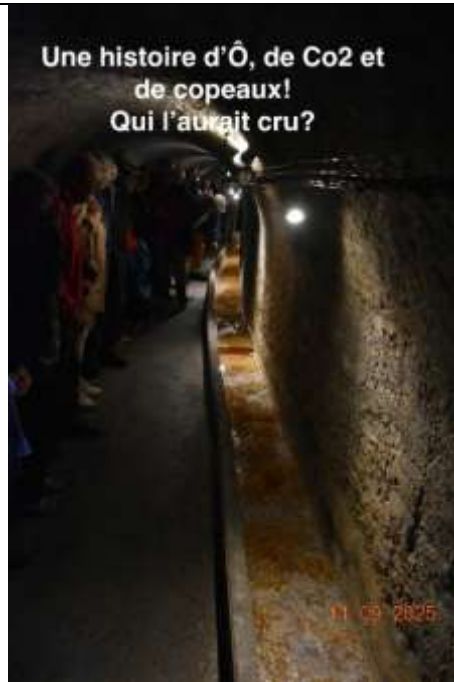
Filtrage des eaux avec des copeaux de bois
