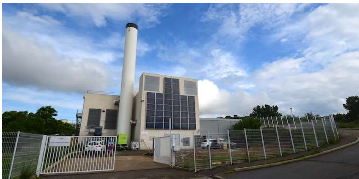
La chaufferie bois de l'hôpital d'Alès a été mise en service en 2011 avec deux chaudières Compte R. totalisant 1,6 MW © F. Douard
