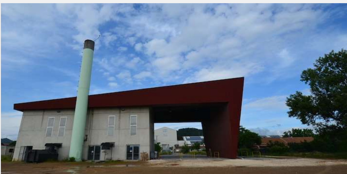
La chaufferie urbaine d'Alès
