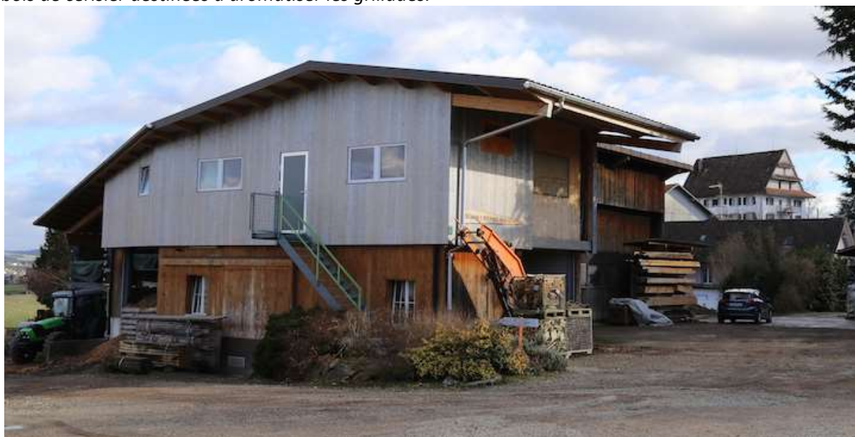
La centrale de chauffage à la ferme de Wittenwil
