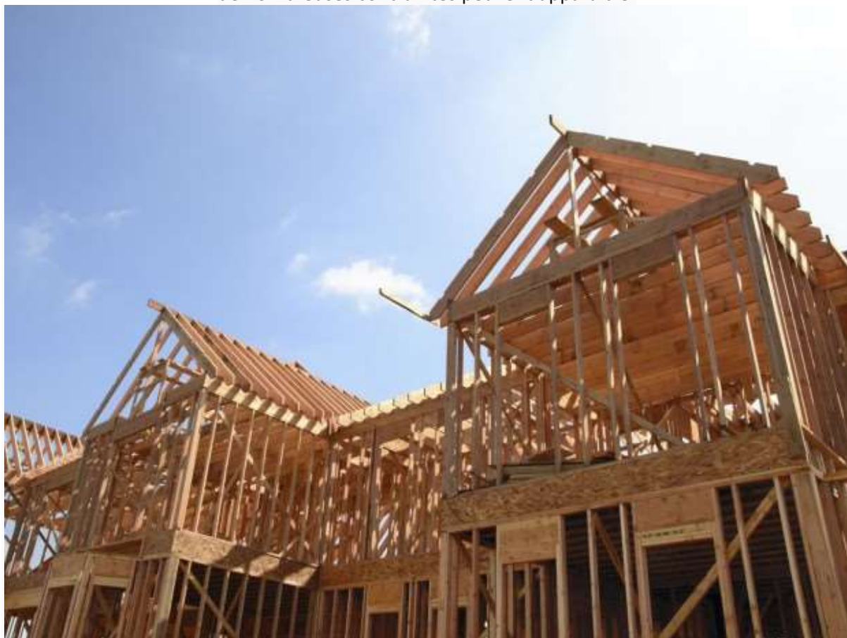
Construction de maison à ossature bois © Luckie8
