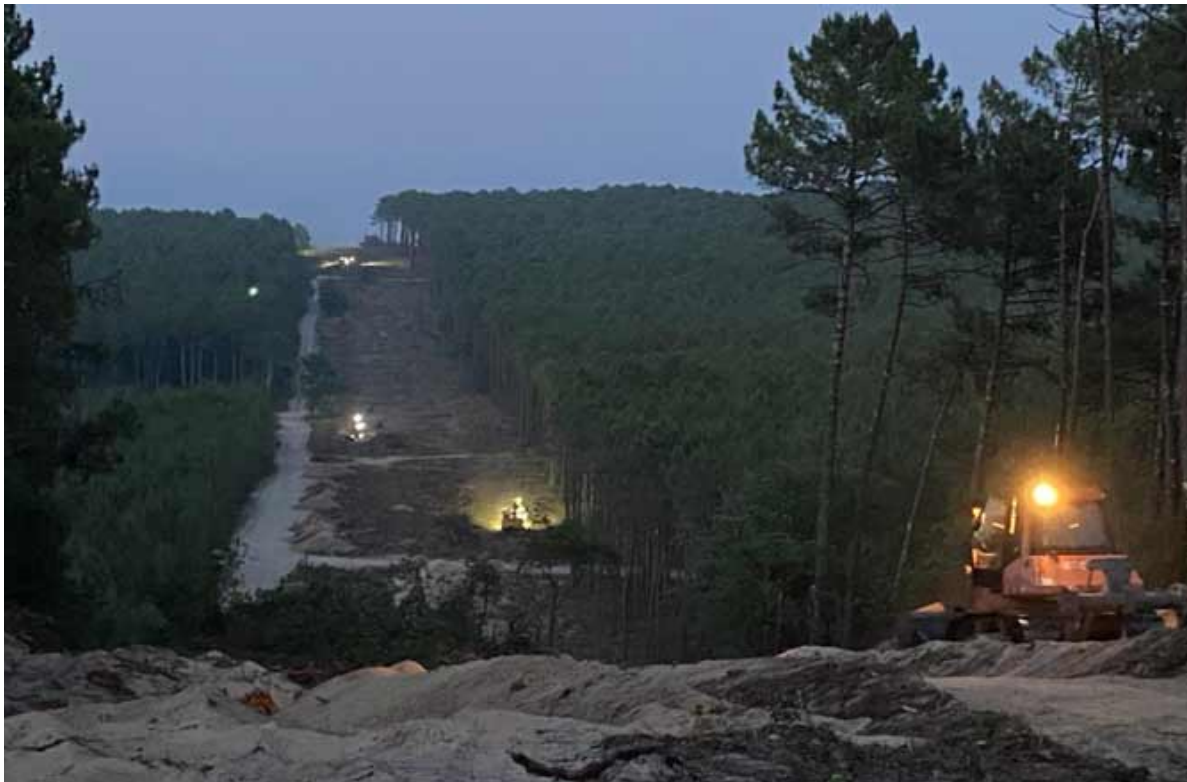
Chantier de création d'un pare-feu en vue de contrer les incendies, durant l'été 2022, en Gironde (crédit photo: FNEDT)
