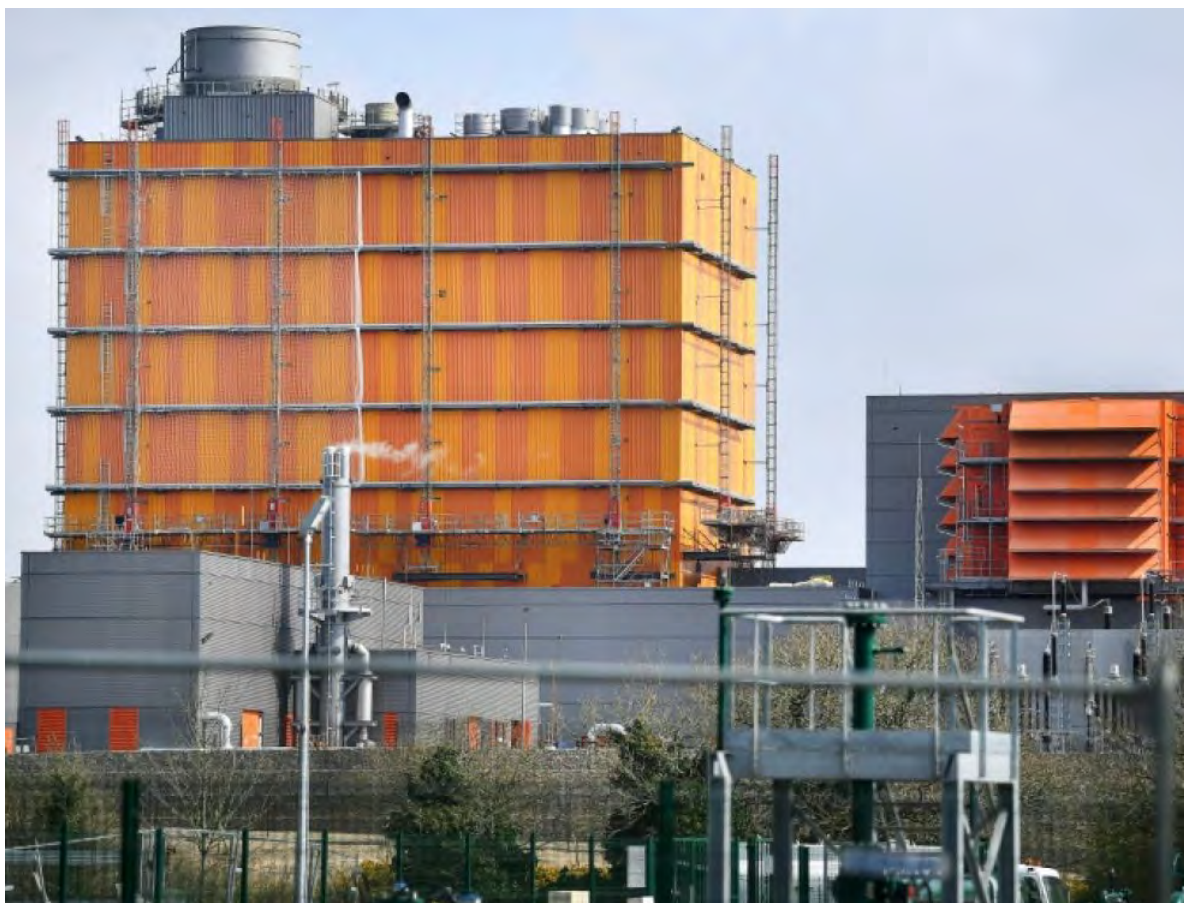
La nouvelle centrale à gaz de Landivisiau, dans département du Finistère
