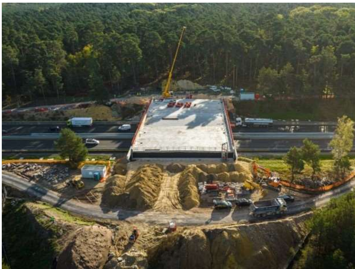
Travaux sur l'écopont d'Ermenonville, sur l'autoroute A1. © Drone press pour Sanef
