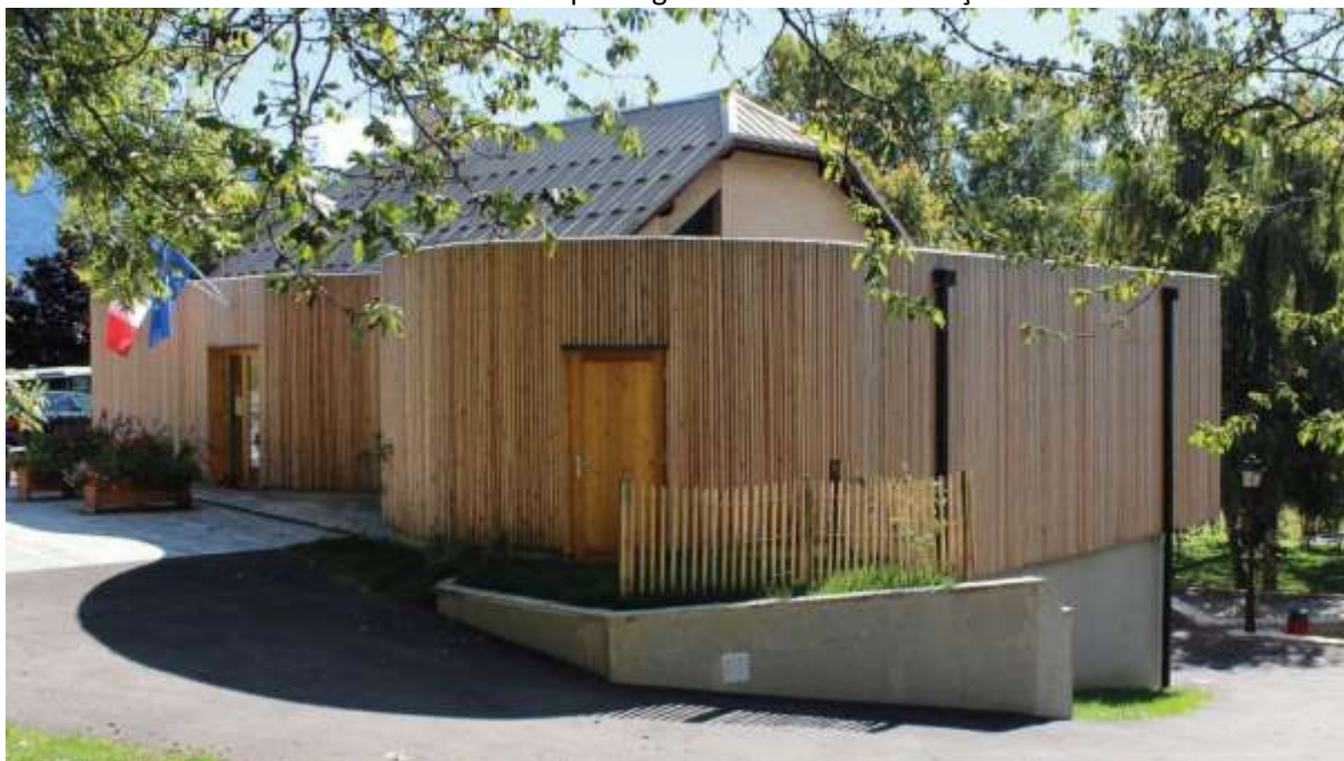
Extension de la mairie de Puy-Sanières (Hautes-Alpes) en bois des Alpes - ©Communes forestières - architecte Agence des Territoires de Montagne
